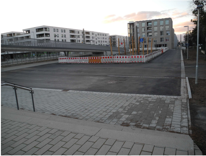
Brückenplatz Nord, Blick von Osten
